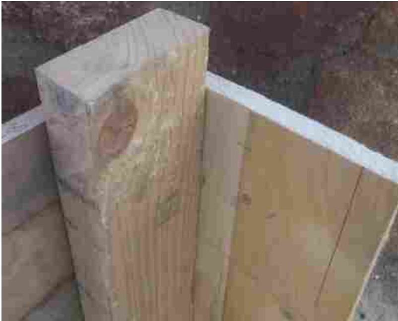
Detalle de dos piezas fijadas en 90° listas para atornillar. Foto: Fernando Calderón.
