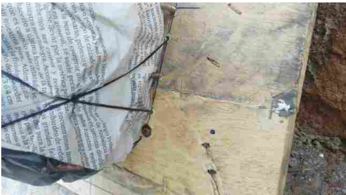
Hay que dejar los tornillos bien expuestos. Foto: Fernando Calderón.
